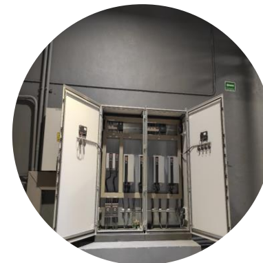
Fabricación de tableros de control
